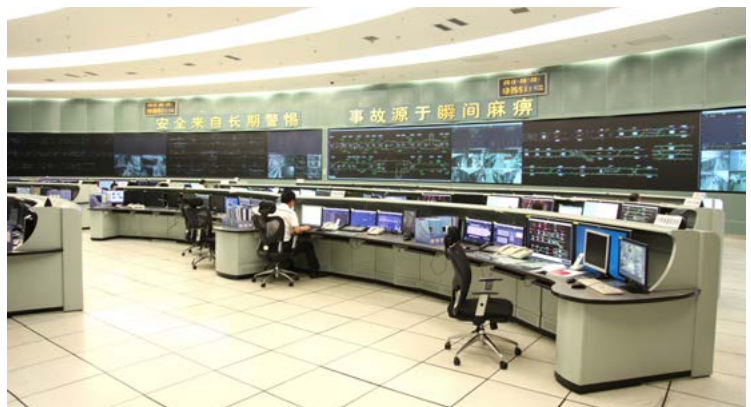
▲中国通号以系统集成及施工总承包完成重庆轨道交通1、6号线“交钥匙”工程
