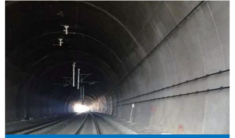
云桂铁路公网覆盖项目平果6号隧道公网漏缆
